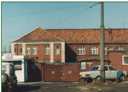
Здание довоенной постройки, в котором размещалось основное производство Калининградской геоконторы с октября 1977 г. по декабрь 2001 г.
